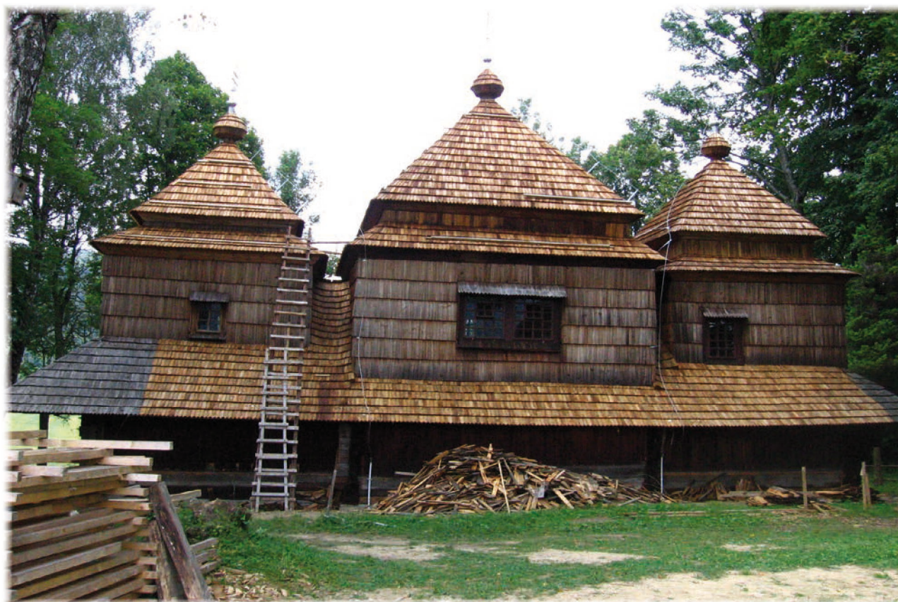
Smolnik nad Sanem. Cerkiew drewniana św. Michała Archanioła. Widok od strony południowej, stan w trakcie wymiany poszycia gontowego. Fot. D. Nowak, 2005.
