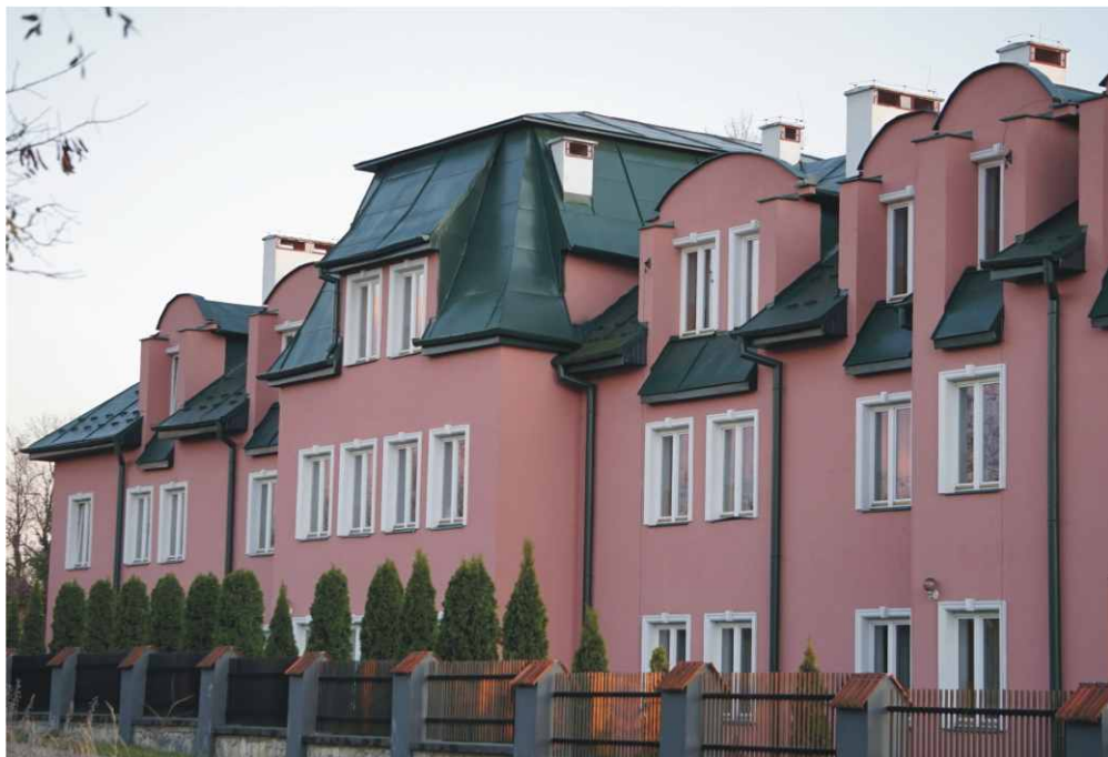
6. Pałac w Rudzie Różanieckiej. Elewacja północna (fot. Robert Gmiterek)
